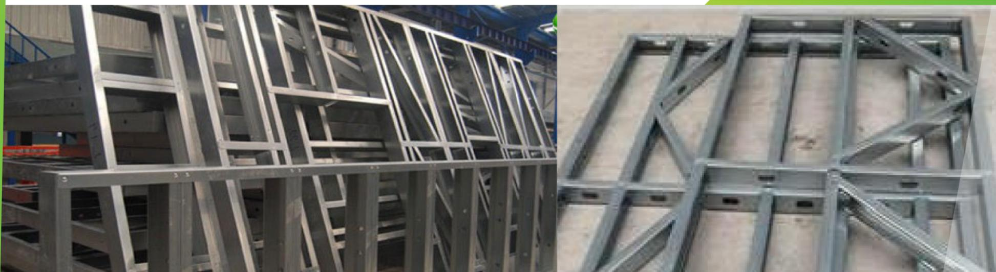
Les structures en acier léger ont une forte résistance sismique en raison de la flexibilité du système de construction, car toute la structure est vissée. La durabilité de ce type de constructions est également élevée en raison des caractéristiques de base de l'acier et de son faible besoin de maintenance au cours des années.
